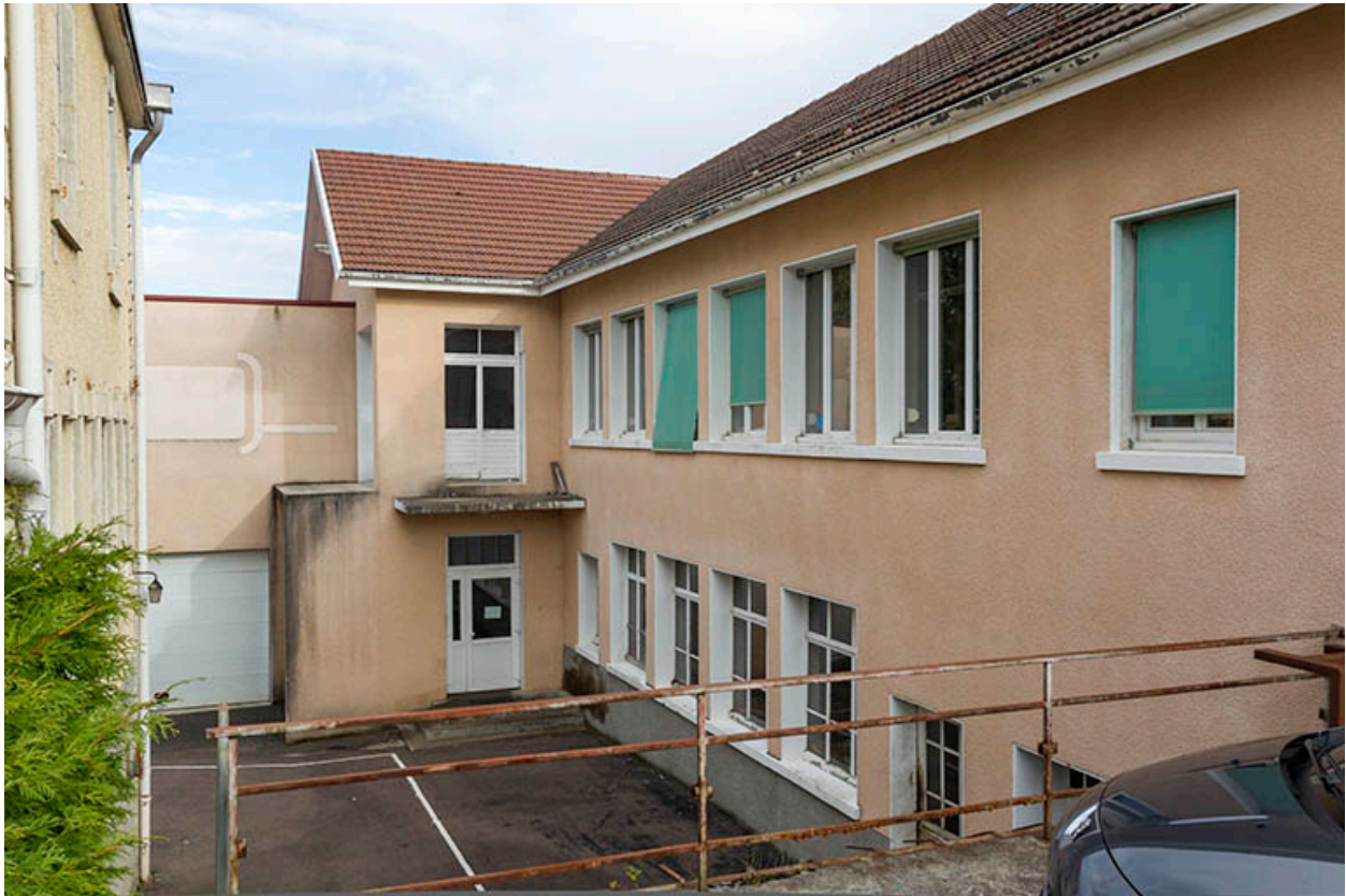
Usine : façade latérale gauche, depuis la Rue Neuve.
