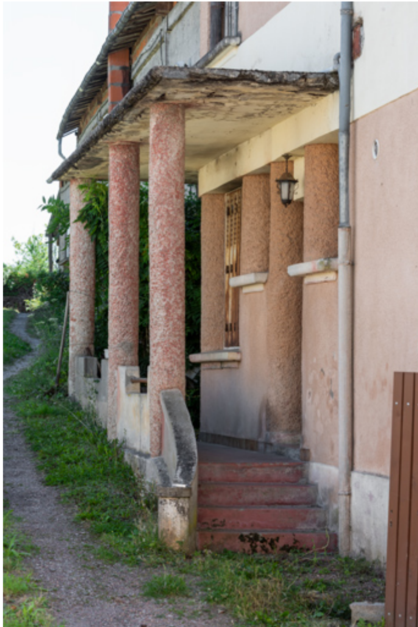
Façade latérale gauche : escalier couvert.
