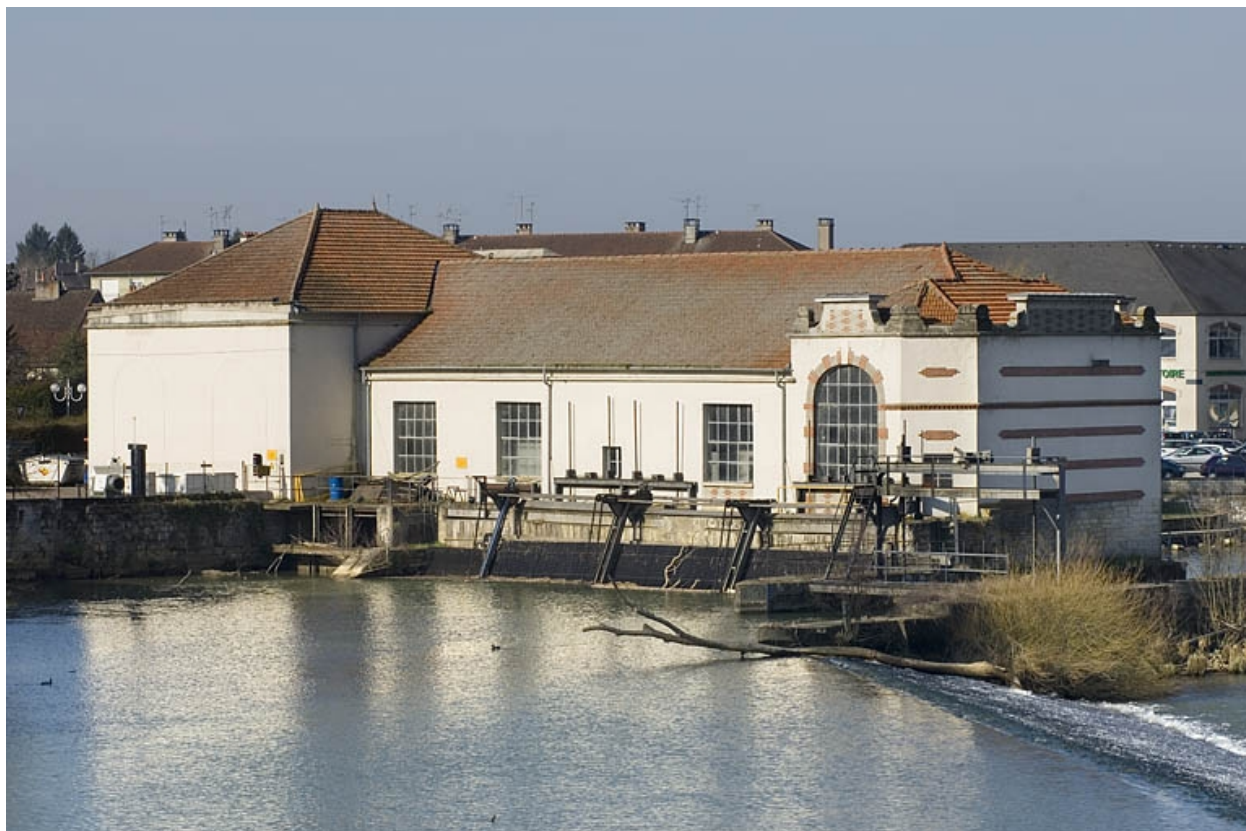
La centrale hydroélectrique vue de trois quarts.
