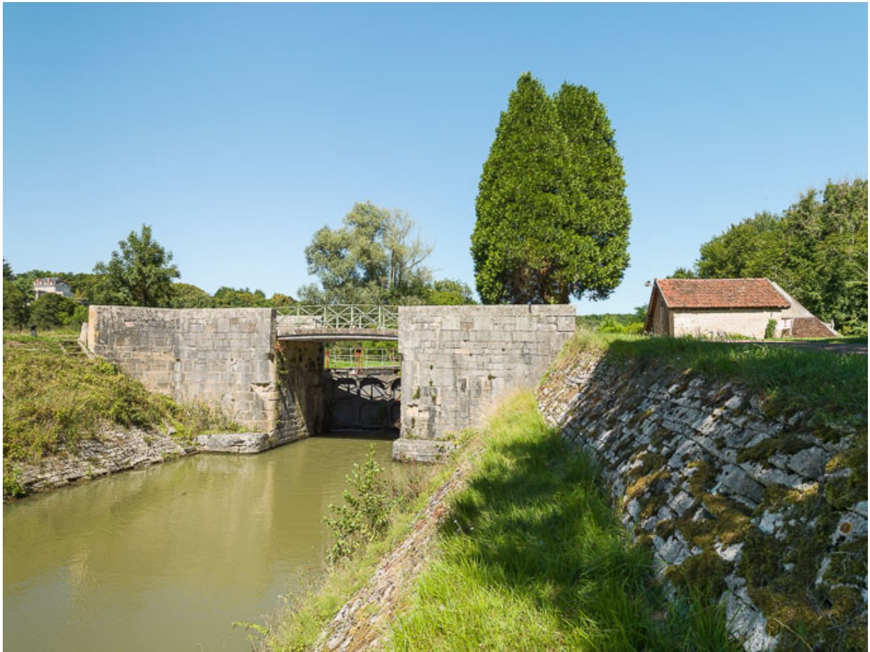
Vue d'ensemble du pont.
