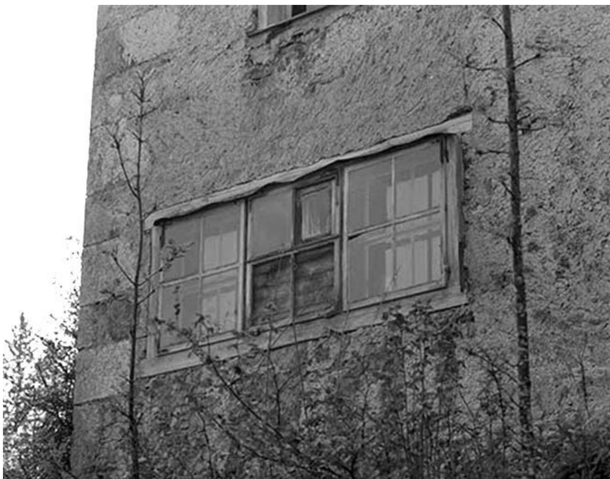
Fenêtre triple sur la façade postérieure.
