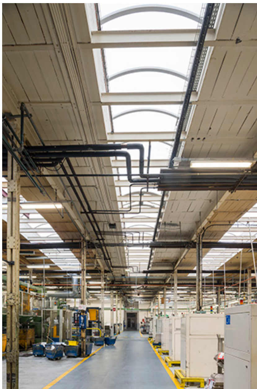
Atelier principal. Eclairage zénithal par travées.
