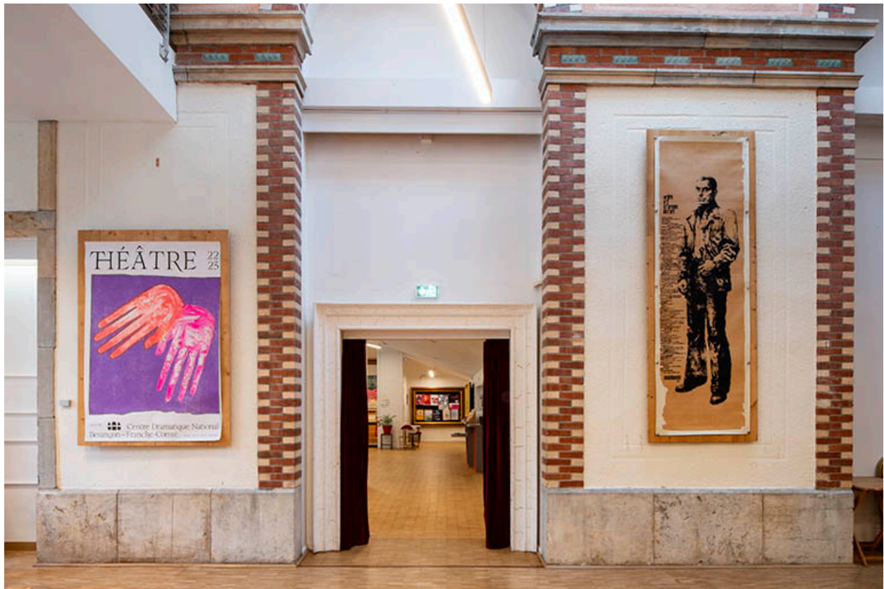
Façade latérale, aujourd'hui donnant dans l'extension de 1993.
