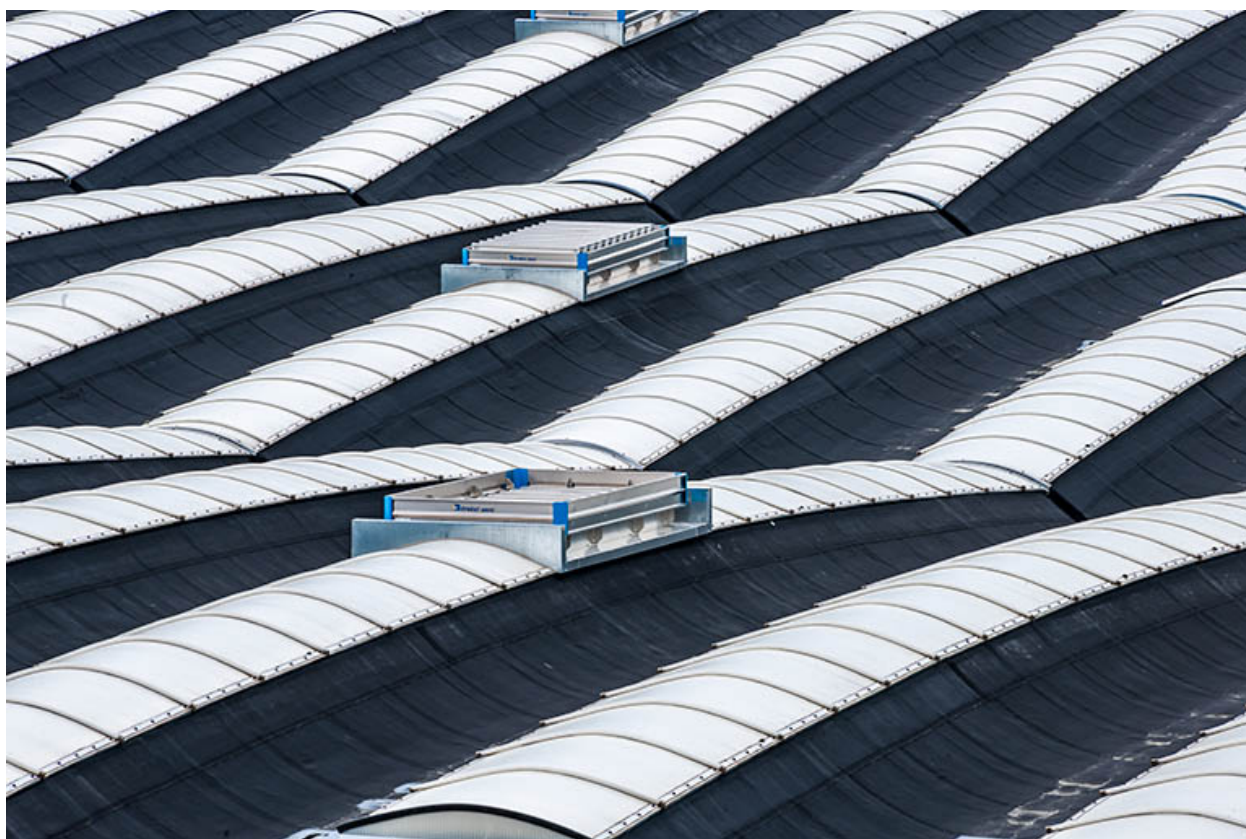
Ateliers : détail de la toiture
