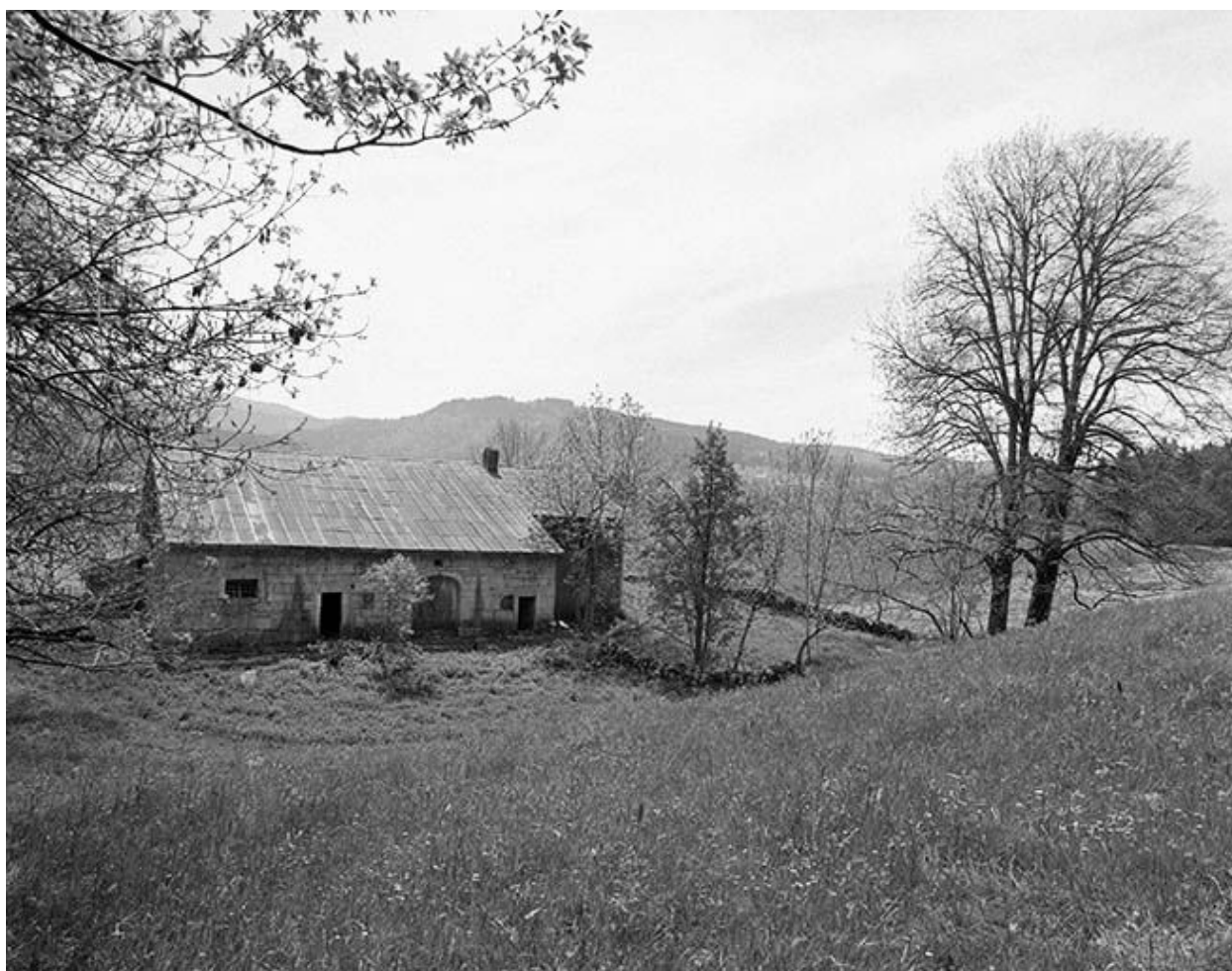
Vue éloignée de la façade postérieure.
