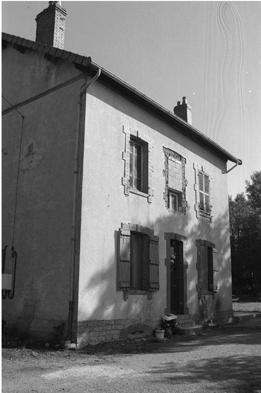
Logement d'ingénieur, vu du nord-est.
