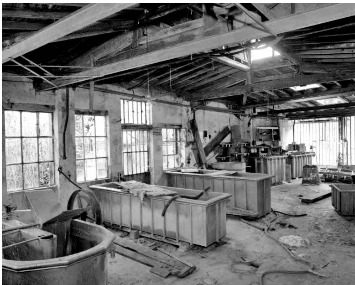
Intérieur de l'atelier de teinture (bâtiment P).
