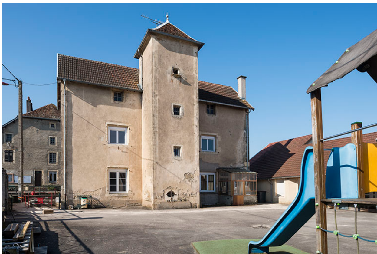
La maison depuis la cour de l'école.
