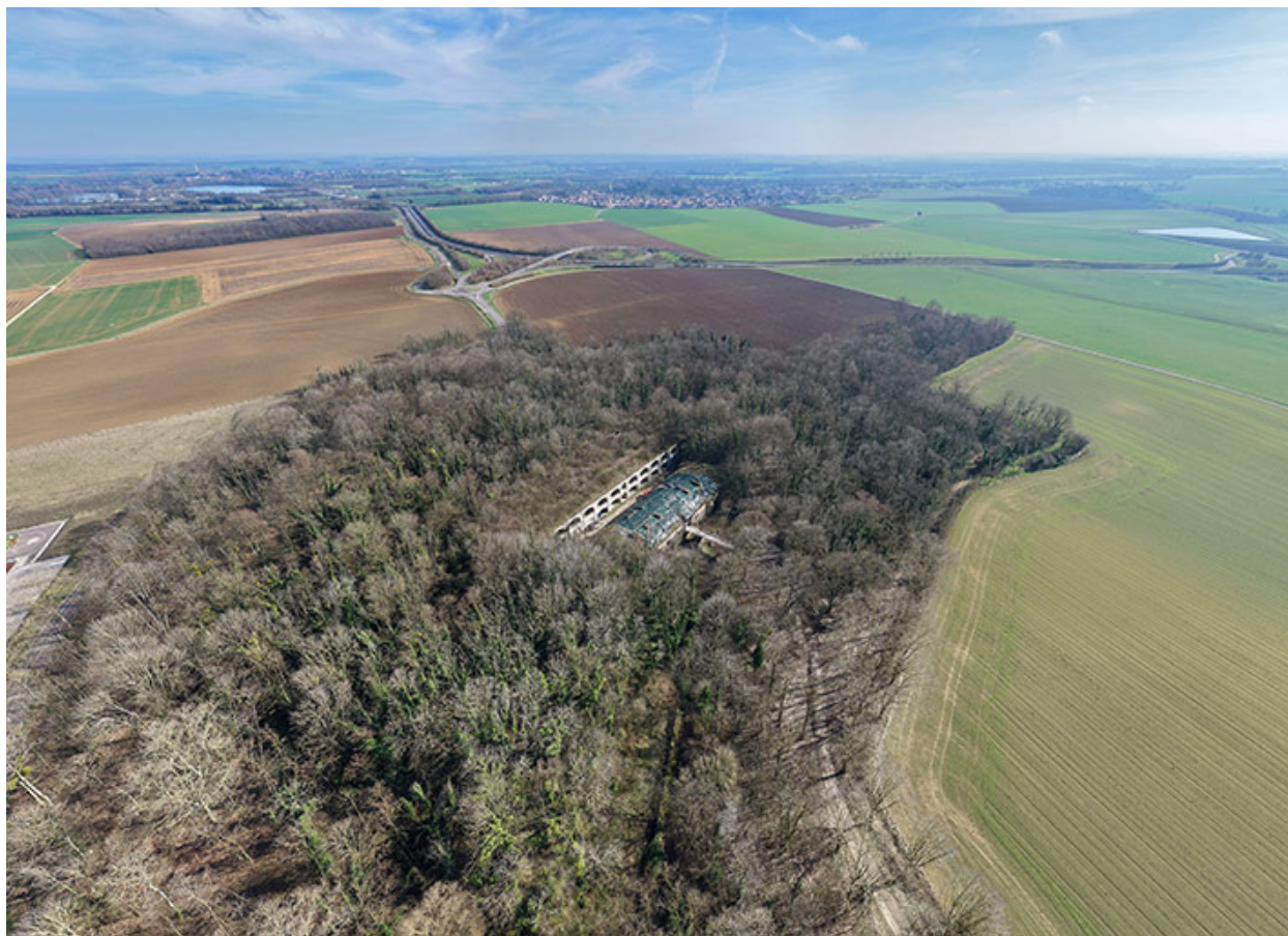
Fort de Varois. (vue aérienne).
