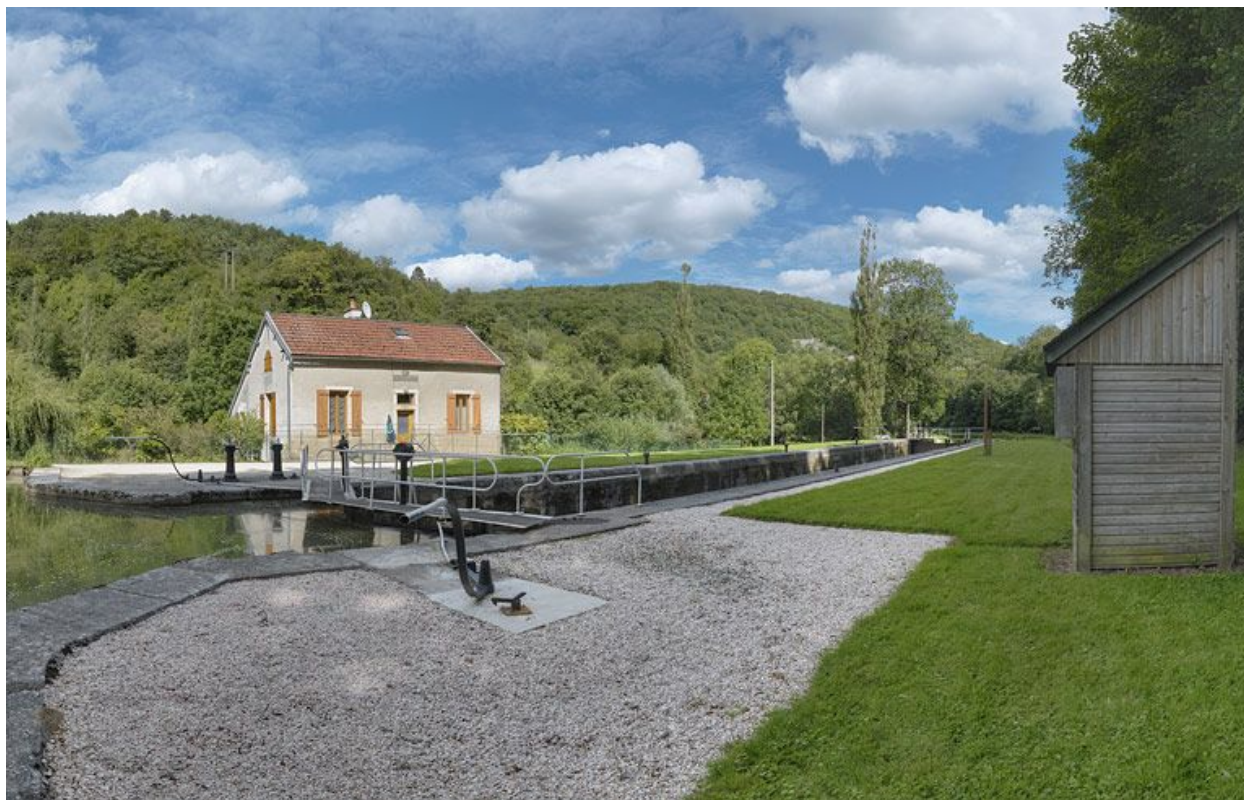
Vue d'amont du site d'écluse 17.
