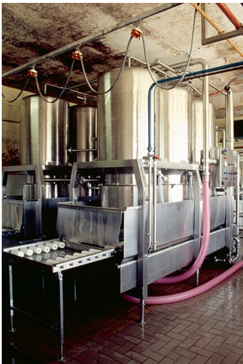
Cloches de l'installation de soutirage sous vide.
