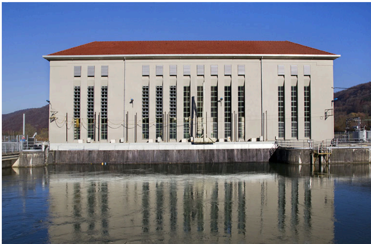
Centrale hydroélectrique de Dampjoux, Noirefontaine.
