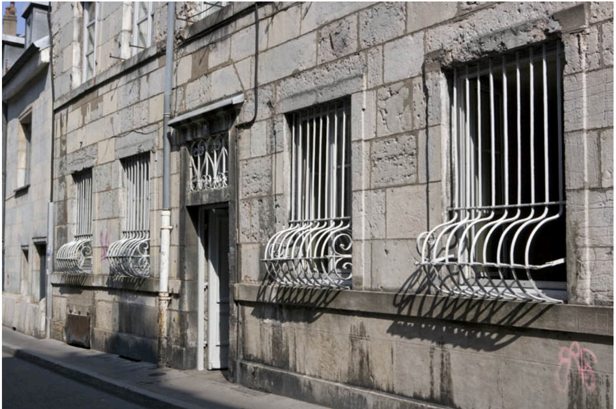
Façade sur rue : détail du rez-de-chaussée, de trois quarts droit.
