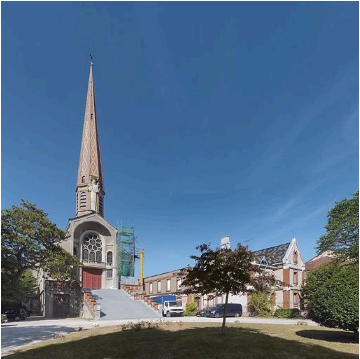
Eglise, chapelle et presbytère. Vue de trois quarts.
