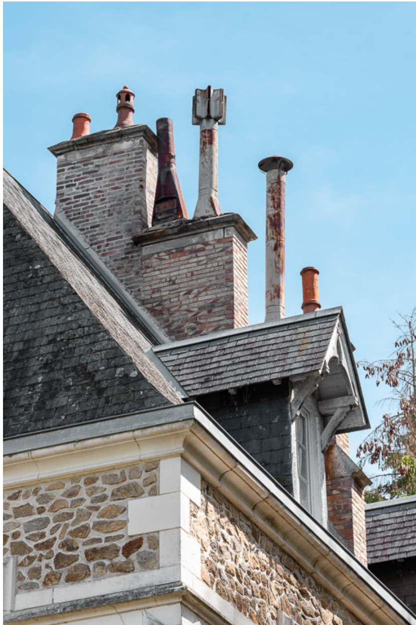
Couverture en ardoise, lucarnes et cheminées.
