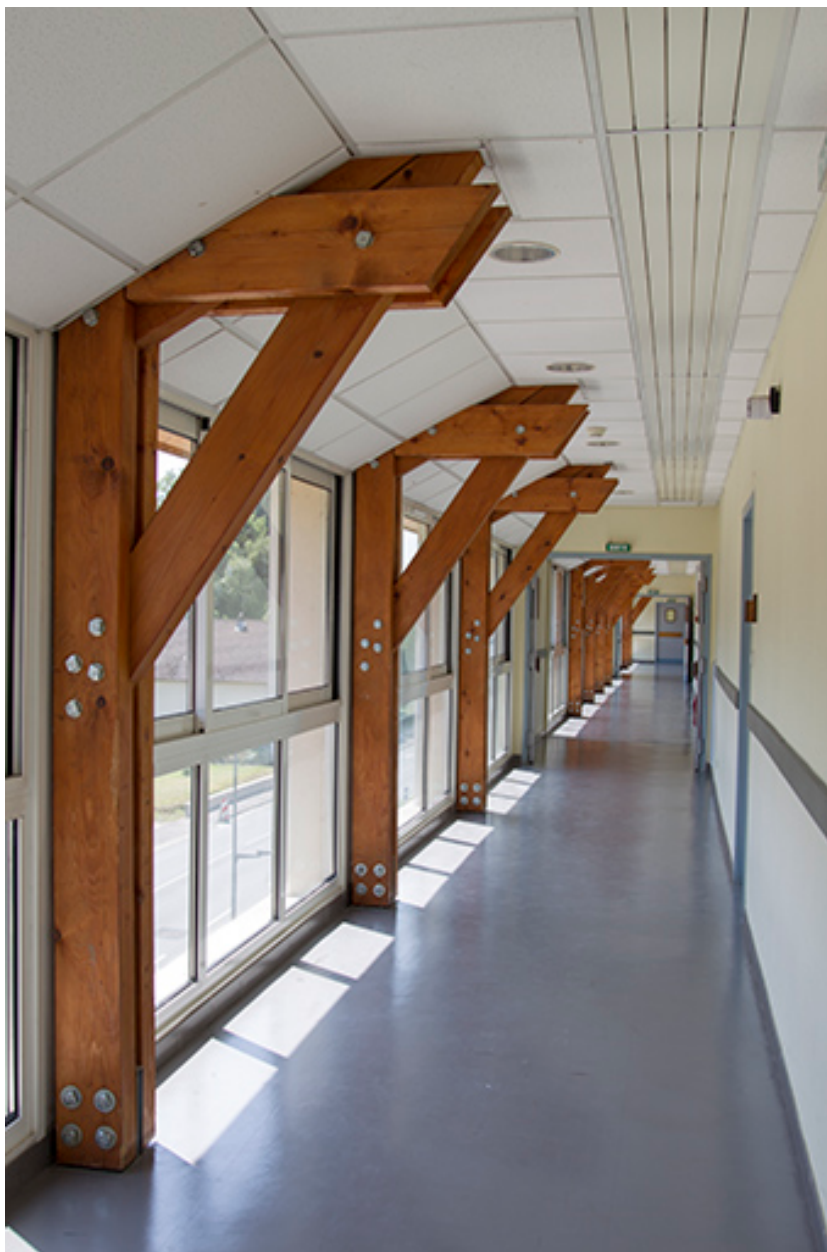
Détail de circulation intérieure de l'externat nord-est.
