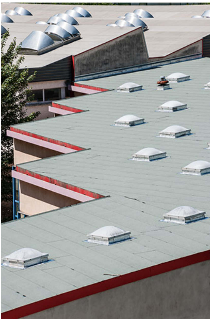
Toitures des deux ateliers : détail.
