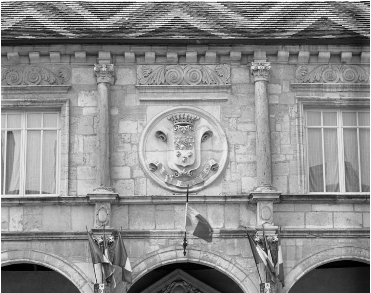
Façade antérieure : détail de la travée centrale du premier étage.
