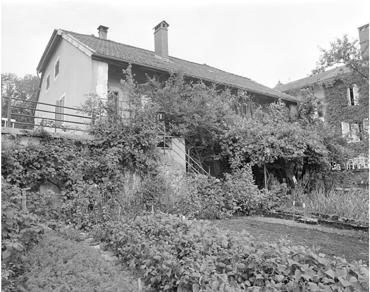
Façade postérieure de l'ancienne maison commune.
