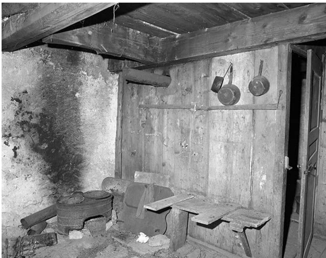
La cuisine : emplacement de la cuisinière.
