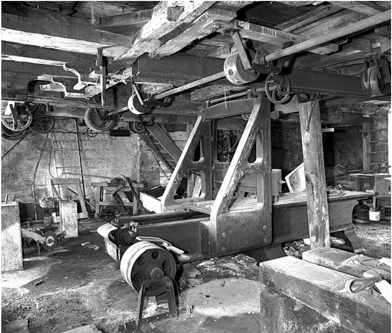
Partie arrière : poulies et engrenages d'entraînement de la table. En côté de l'entretoise, manivelle de réglage en hauteur de la traverse porte-outil.
