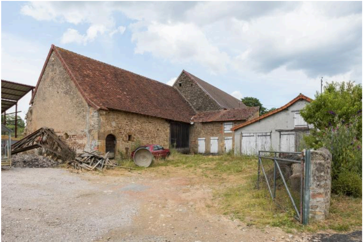
Vue des anciennes dépendances, partiellement détruites
