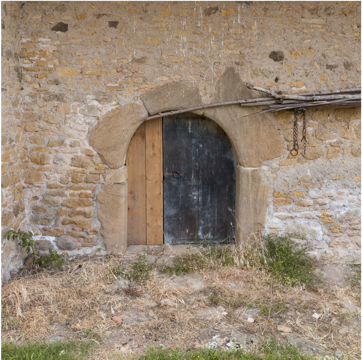
Façade antérieure du bâtiment agricole. Porte cintrée d'une étable.
