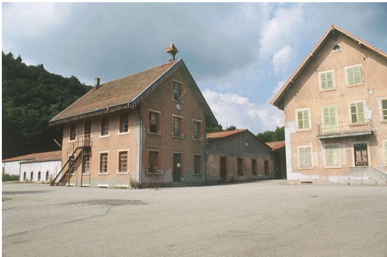
Bâtiments du tissage depuis le sud-est.
