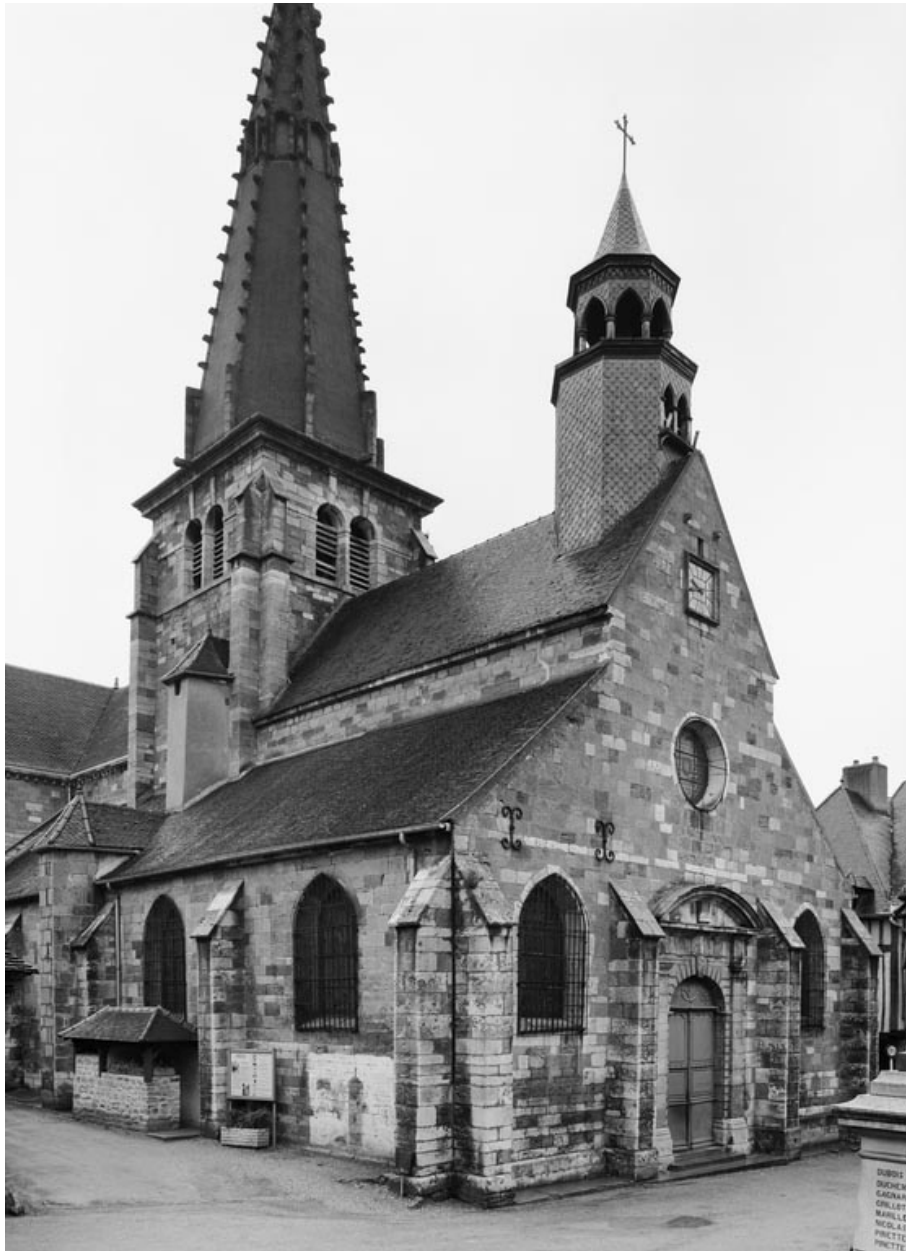
Façade et élévation gauche de la nef.
