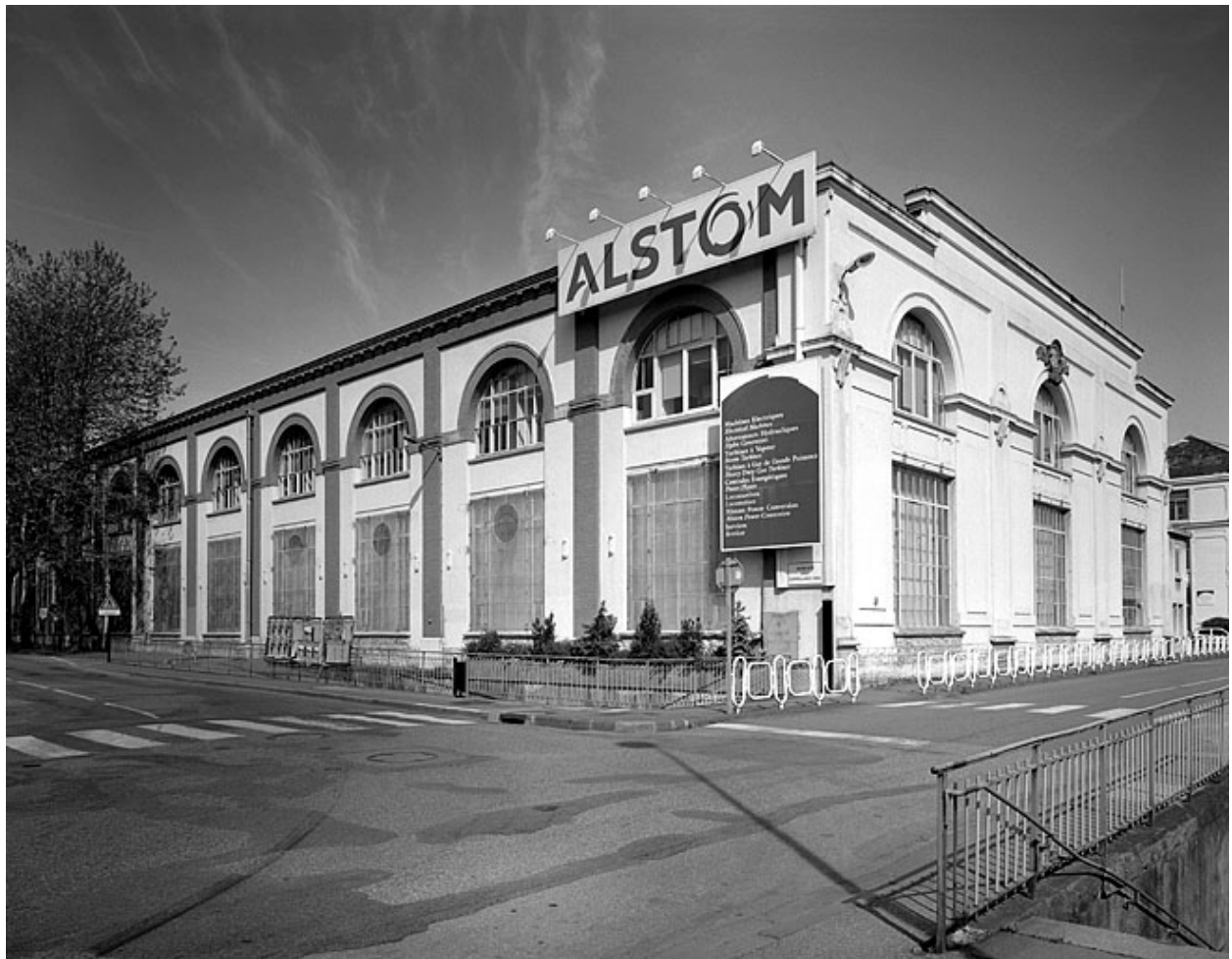
Bâtiment d'entrée à la porte des 3 Chênes.
