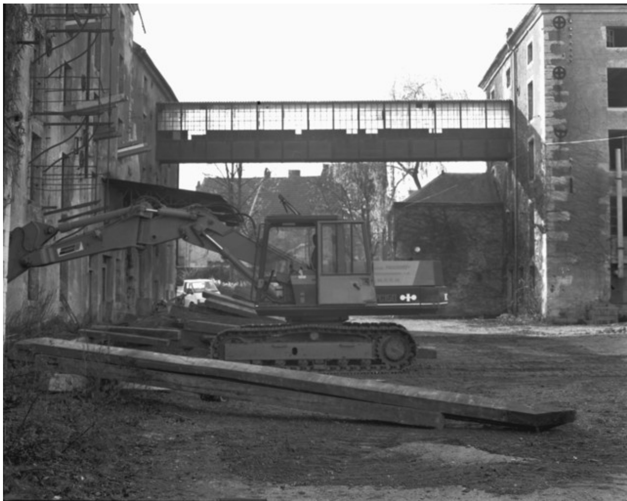
Vue rapprochée de la passerelle en 1989.
