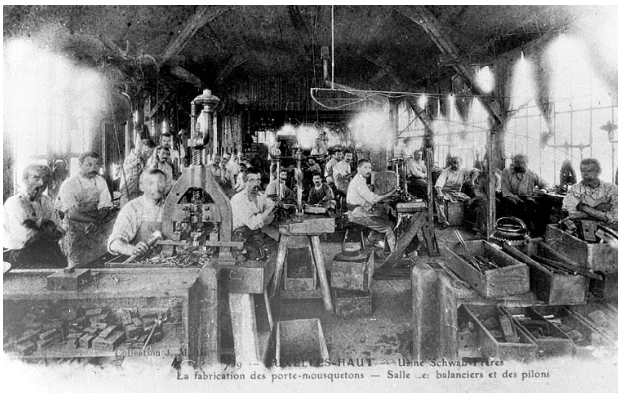
Auxelles-Haut - Usines Schwab Frères. La fabrication des porte-mousquetons. Salle des balanciers et des pilons.
