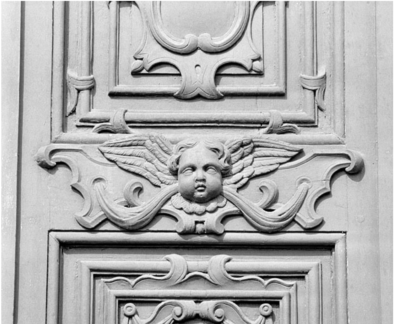
Façade principale, détail de la menuiserie de la porte de droite.
