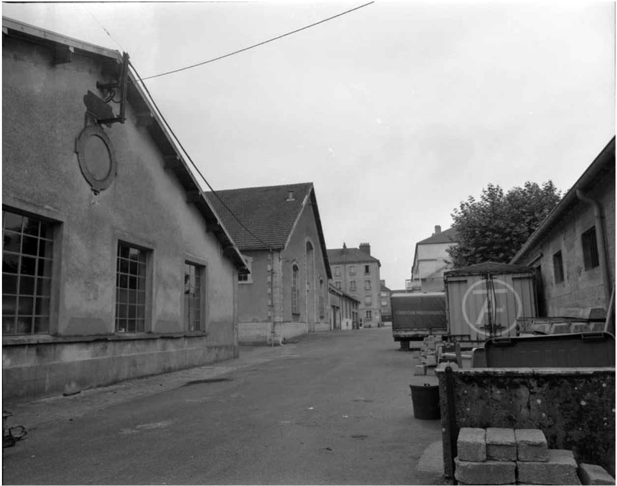
Extension de la caserne : bâtiments gauche et central, façades sur cour.
