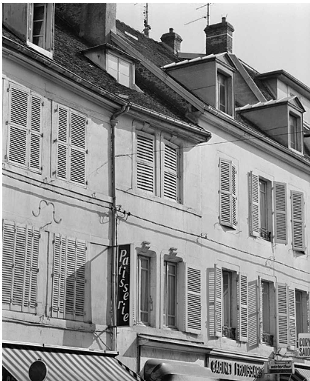
Façade antérieure, premier et deuxième étages.
