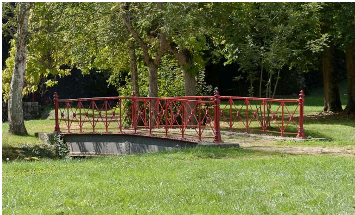
Vue d'un pont sur rigole.
