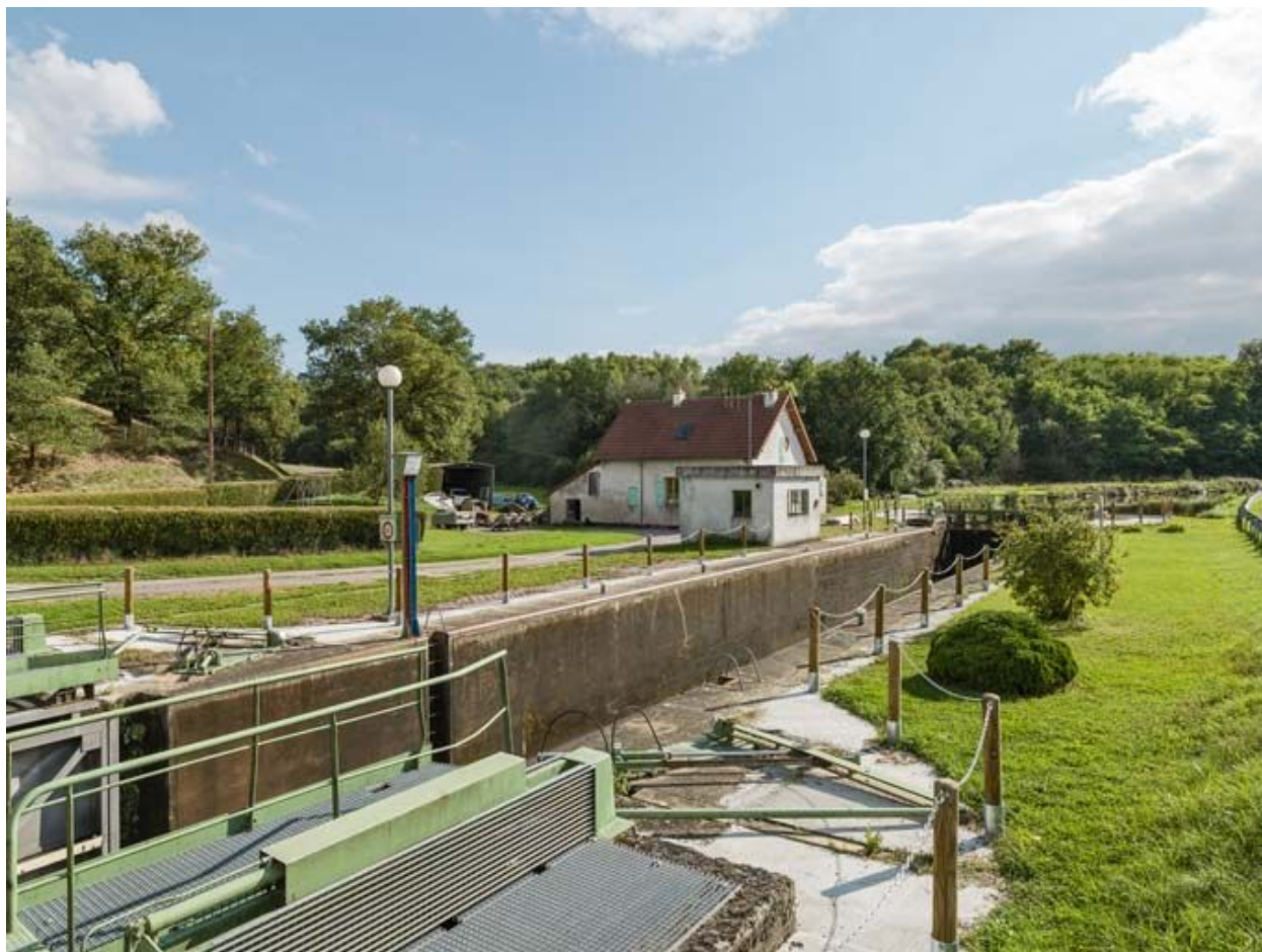
Vue d'ensemble du site d'écluse.
