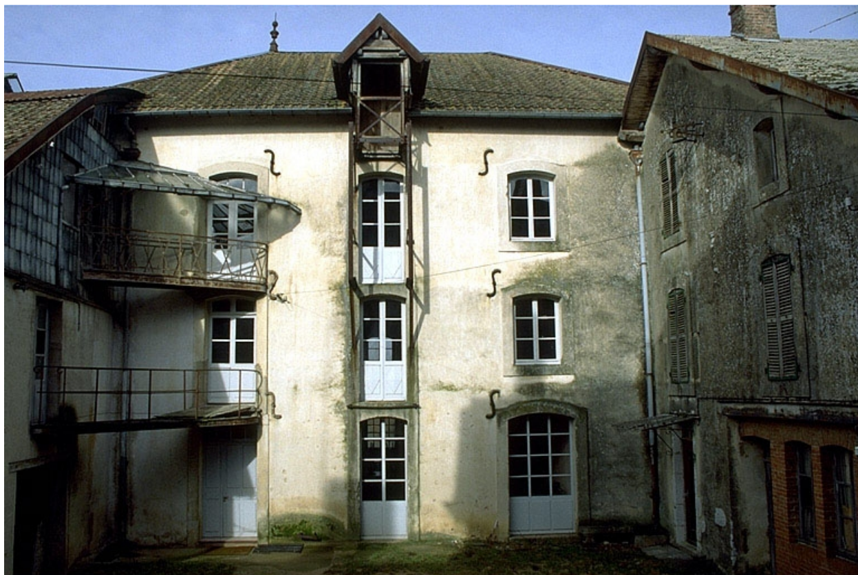
Façade antérieure de l'atelier de fabrication.
