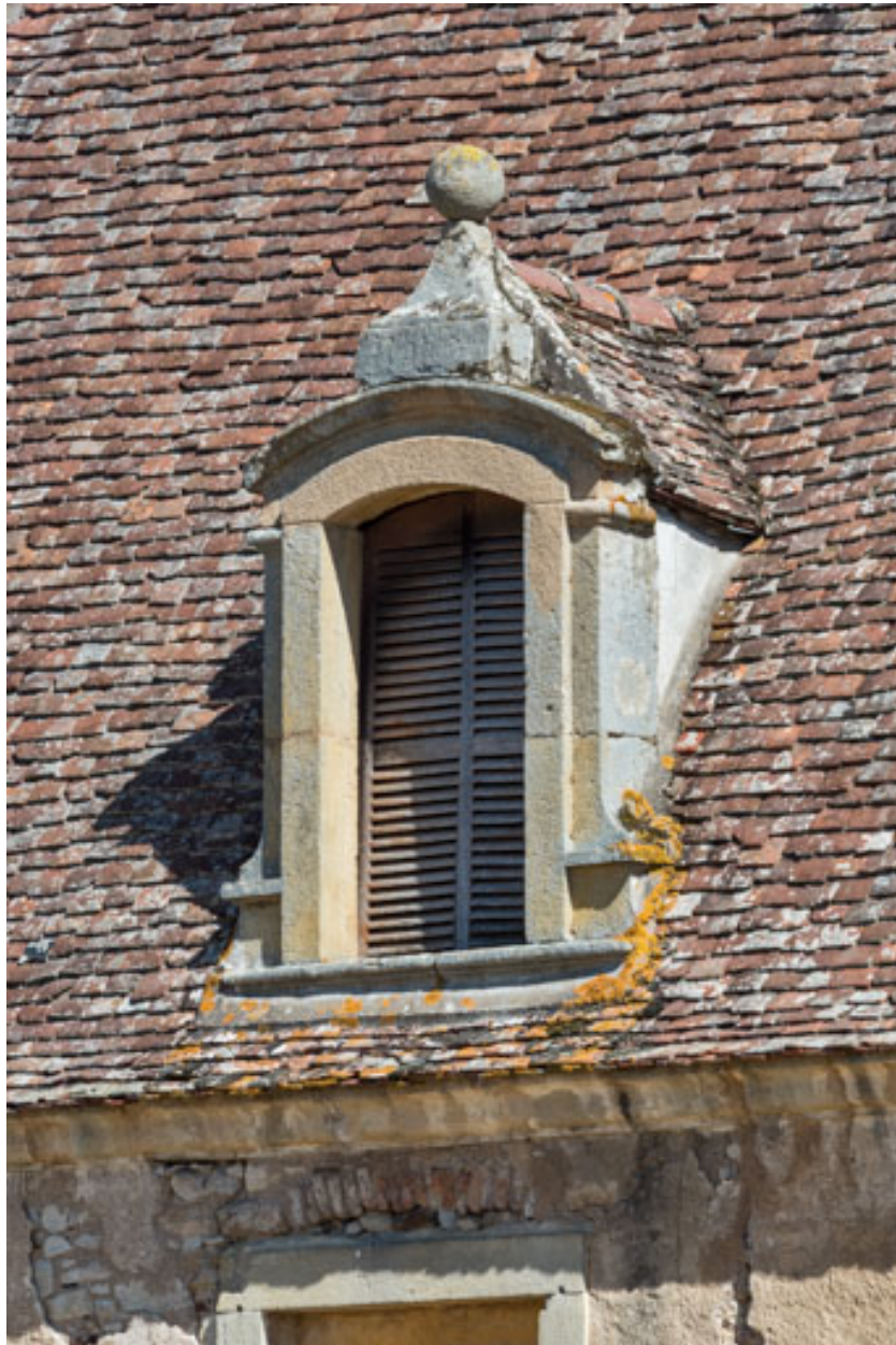
Façade antérieure : lucarne avec motif d'amortissement sphérique.
