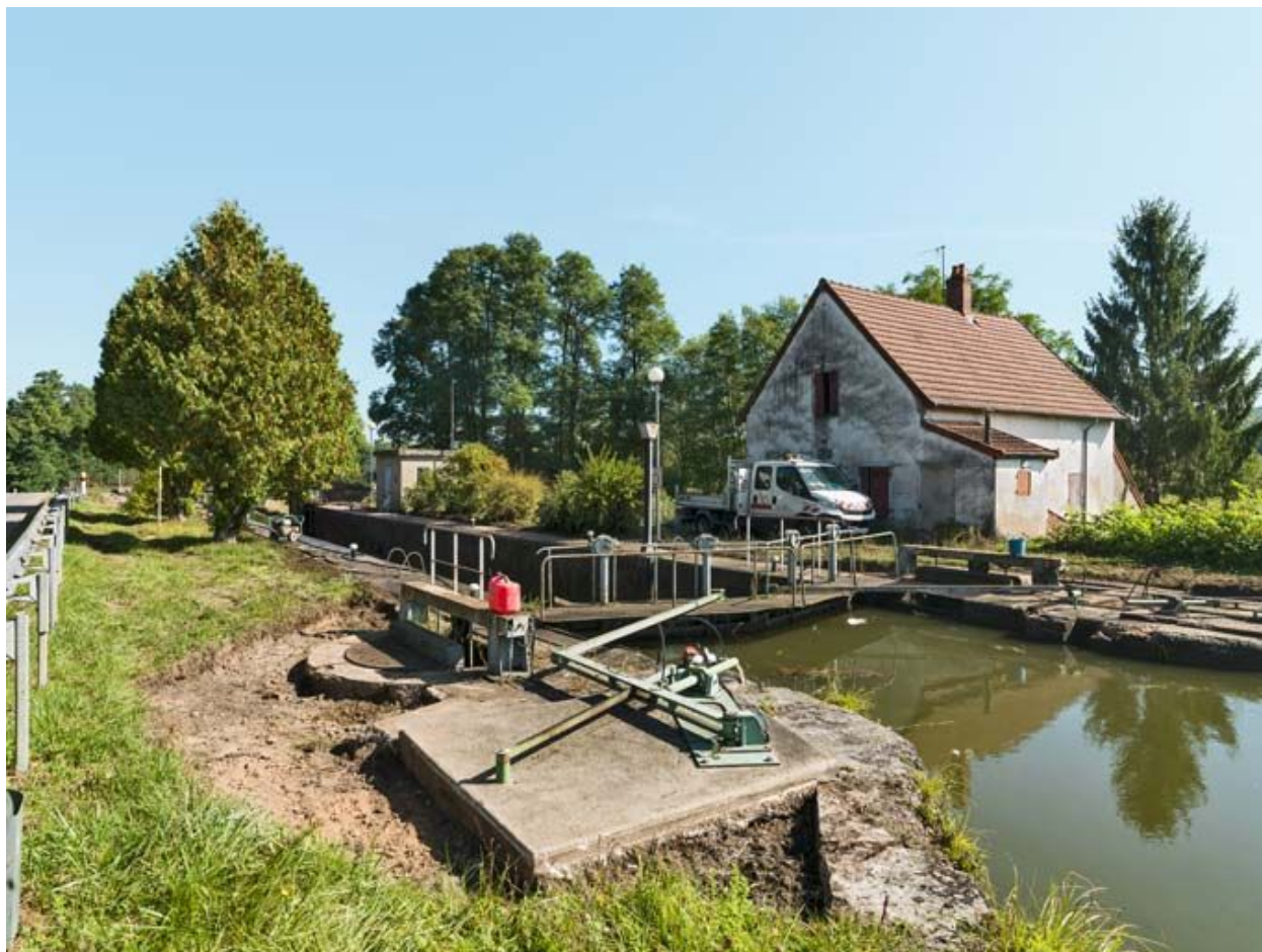
Vue d'ensemble du site d'écluse.
