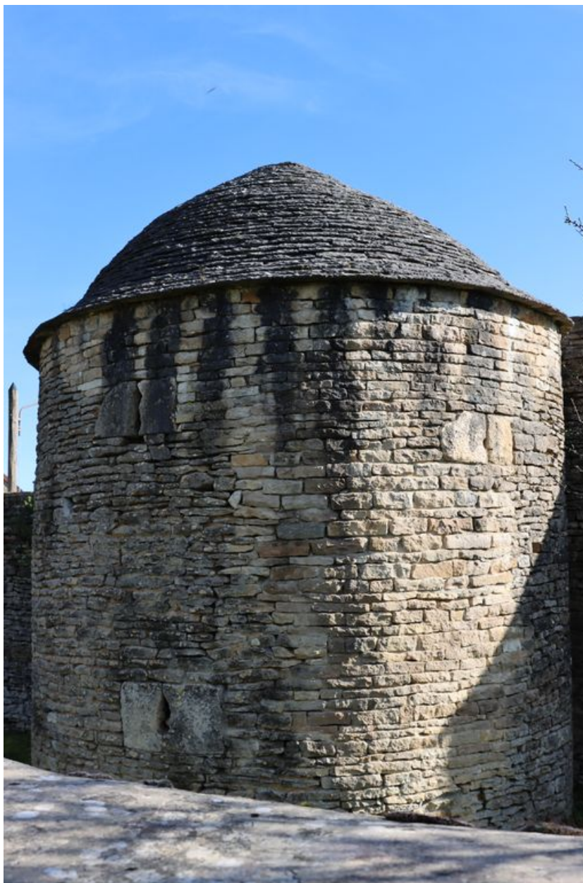
Détail des maçonneries de la tour depuis le nord.
