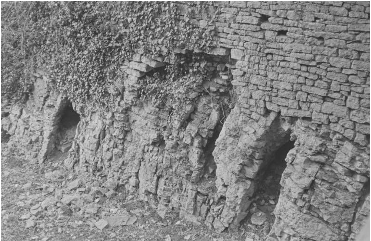
Enceinte : l'extérieur. Détail : appareil et dégradations (photo prise en 1969).
