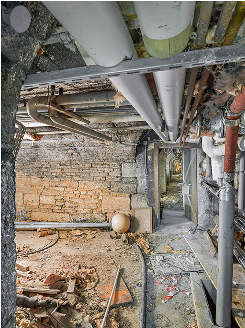
La galerie desservant les casemates du front bastionné, niveau inférieur.
