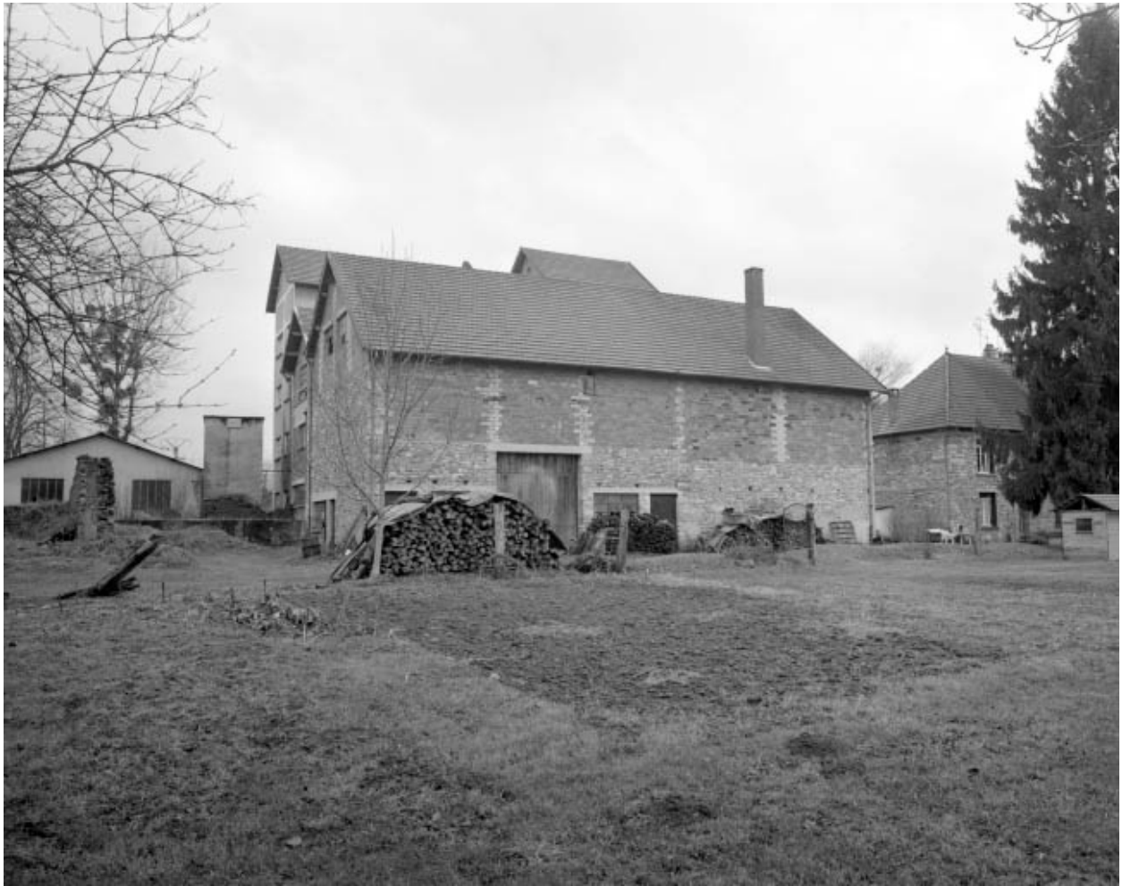
Façades postérieures de la minoterie.
