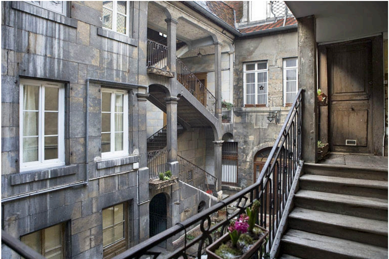
Vue de l'escalier à cage ouverte depuis celui des communs.
