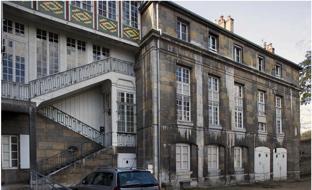
Vue d'ensemble de l'escalier et de l'aile sur cour.
