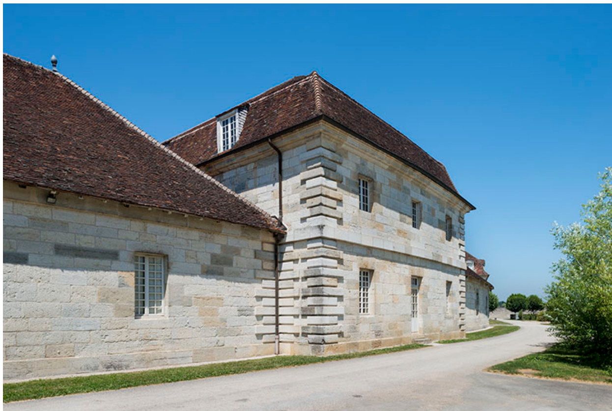
Façade postérieure du logements des ouvriers ouest.
