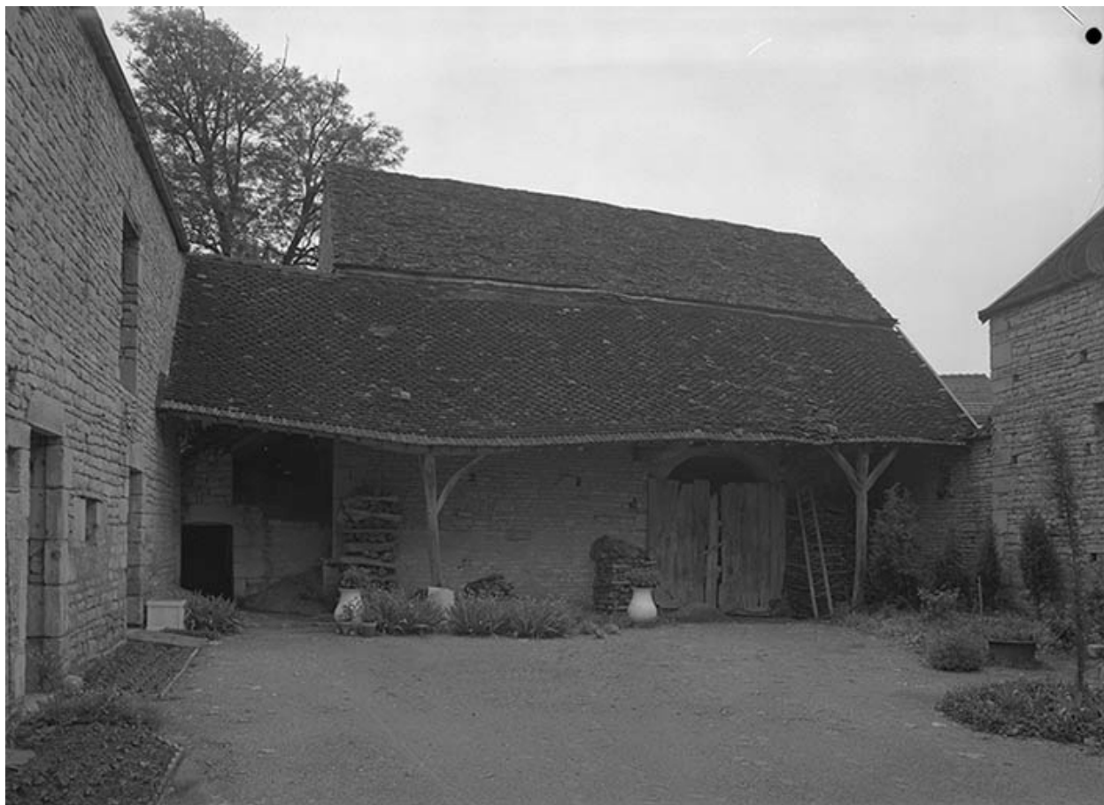
Grange. Façade sur cour.
