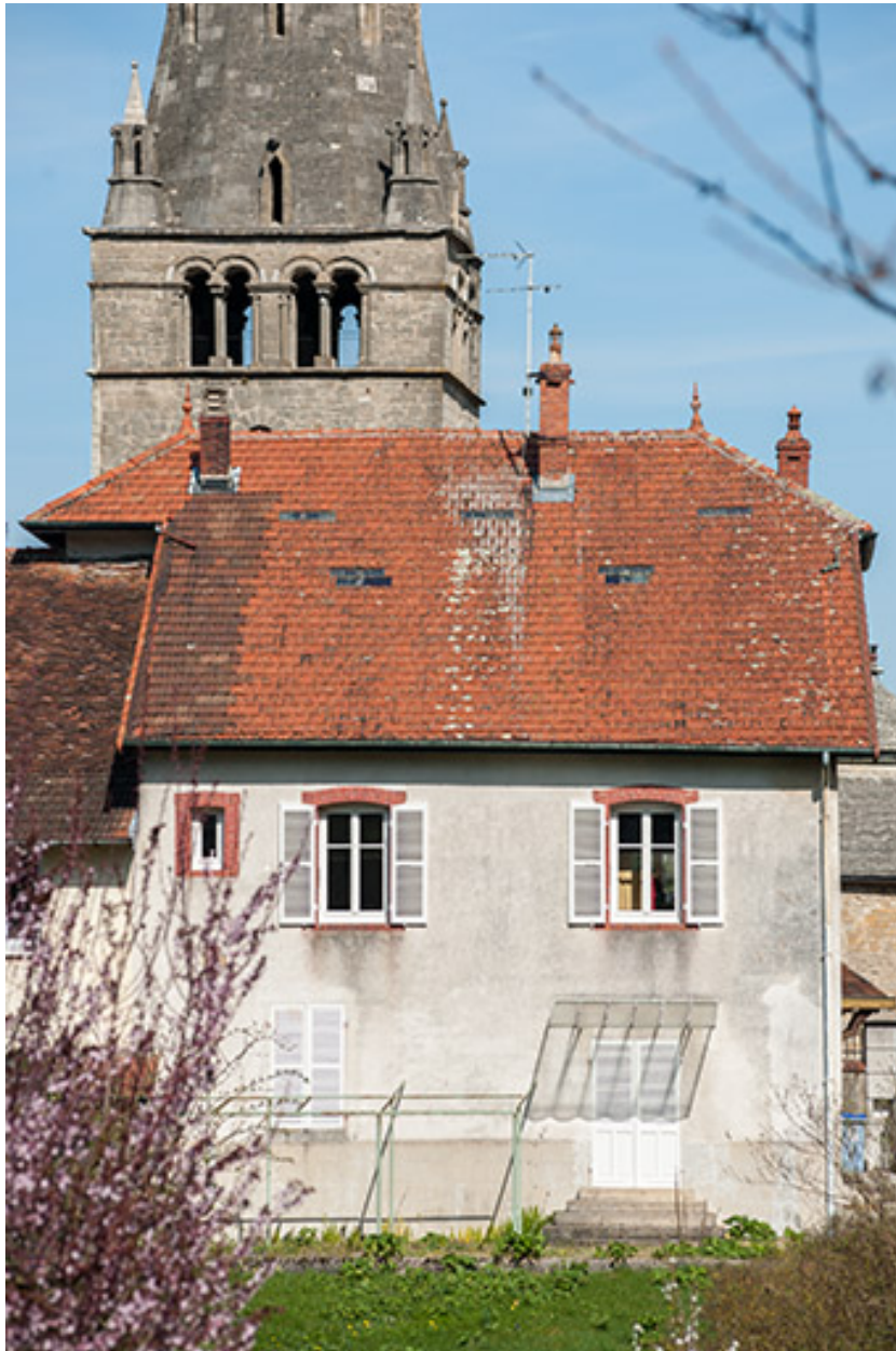
Pignon postérieur de la maison de fonction, 9 place Notre Dame.
