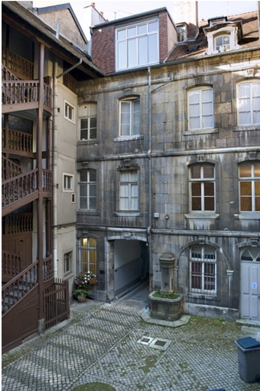
Vue du logis secondaire au fond de la première cour depuis l'escalier droit.
